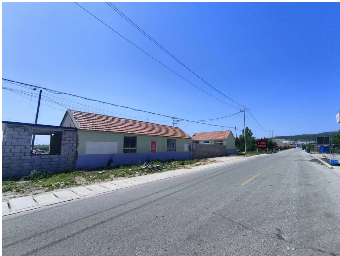
加油站西侧的道路、民用建筑、架空电力线路
