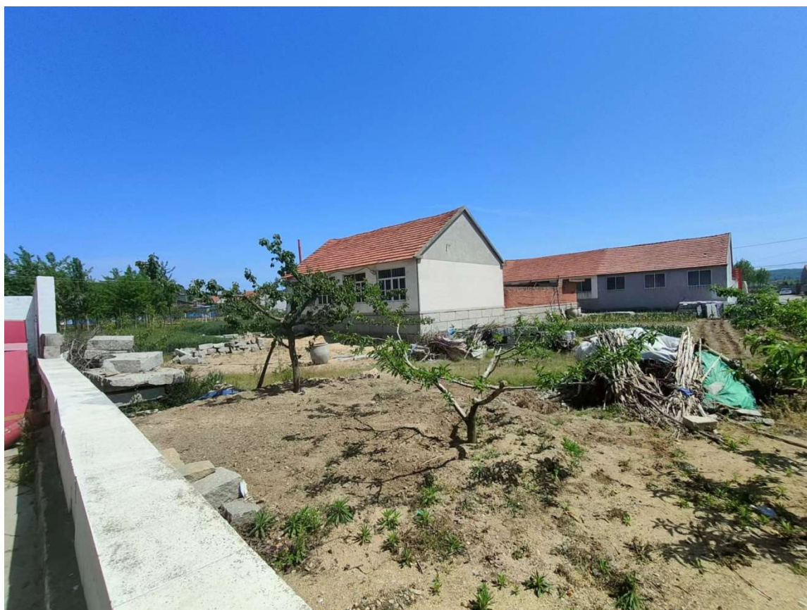
加油站南侧的民用建筑
